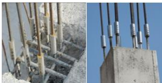
شکل (۱۱) - کوپلر یک سر رزوه در وصله ترکیبی [۸]
